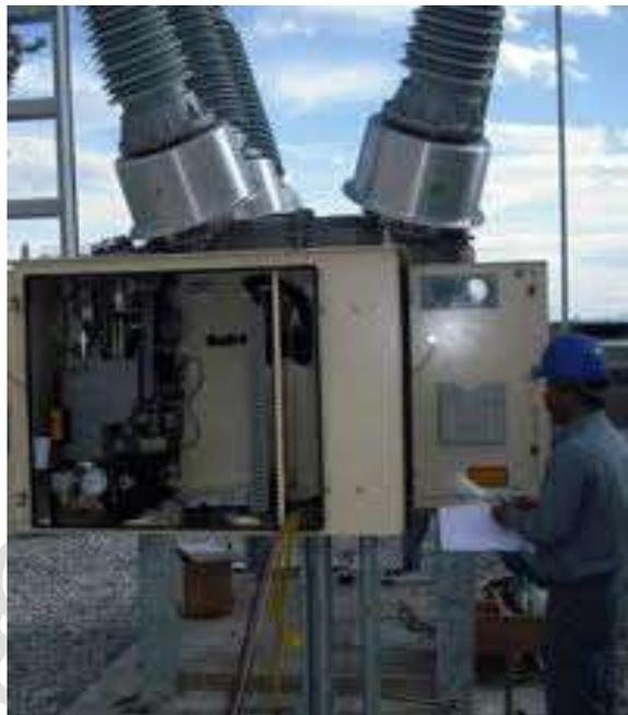
ALCANCE: Desarrollo de la ingeniería y mano de obra para retirar interruptor de alto volumen de aceite y reemplazo por interruptor de potencia en Hexafluoruro de Azufre 115 kV para el transformador 01 de la planta de motores Ford Chihuahua, México.
